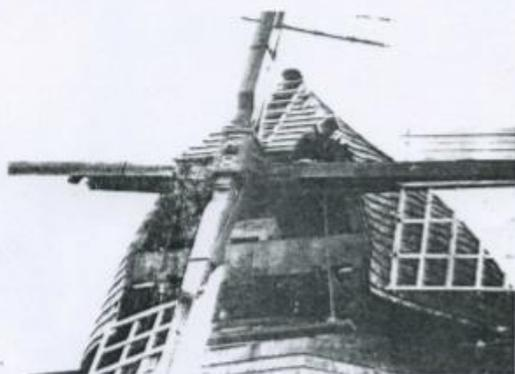
Die Flügel, der Windbalken, der Stert, die Brenne, das Kamrad, der Zapfbalken und Teile der Kappe sind erneuert worden; jetzt läßt sich die Mühle wieder gegen den Wind drehen und die Flügel können laufen.
