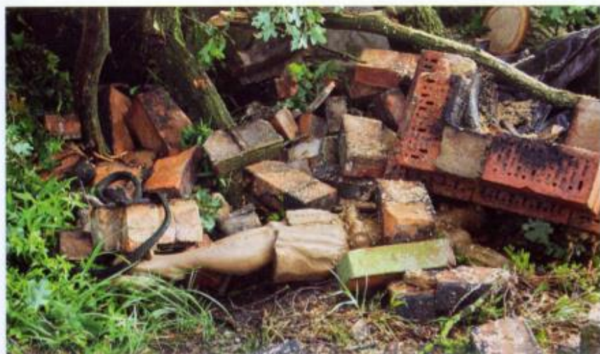
Der zerstörte Korpus unter Trümmern des Backhauses und des Schornsteins
